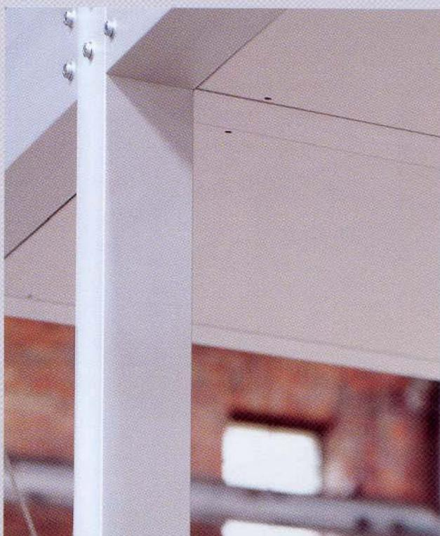
Die Raumdecken-Elemente werden in die Abhängebügel eingefügt.
