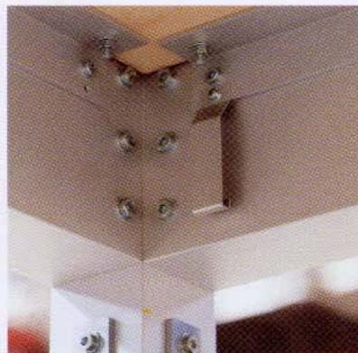
Die Bodenelemente werden fest mit den Auflagewinkel verschraubt.
